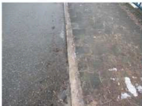
KUNSTWERK (14 en 15) Schade: De hoeklijn langs het voetpad ontbreekt deels. Oorzaak: Vandalisme, verwijderd. Risico: Verminderde functionaliteit. Maatregel: Aanbrengen ontbrekende hoeklijn.
