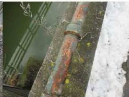
KUNSTWERK (01) Schade: Leuningregel vertoont corrosie en dient verwijderd/vervangen te worden i.v.m. de vervanging van de randelementen. Oorzaak: Klimatologische invloeden en vervanging onderdelen. Risico: Verminderde functionaliteit. Maatregel: Vervangen leuningregel.
