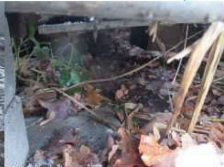
KUNSTWERK (08) Schade: Oplegging ontbreekt/functioneert niet. Oorzaak: Onbekend. Risico: Verminderde functionaliteit en veiligheid. Maatregel: Herstellen/aanbrengen oplegging.
