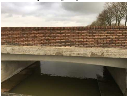
Na renovatie onderzijde brugdek
