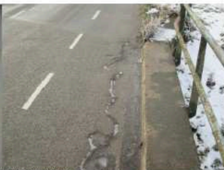
KUNSTWERK (01, 03 en 14) Schade: De asfaltverharding vertoont rafeling, spoorvorming en brokelt af. Oorzaak: Eindelevensduur bereikt. Risico: Verminderde veiligheid (vallen fietsers) Maatregel: Vervangen asfaltverharding.
