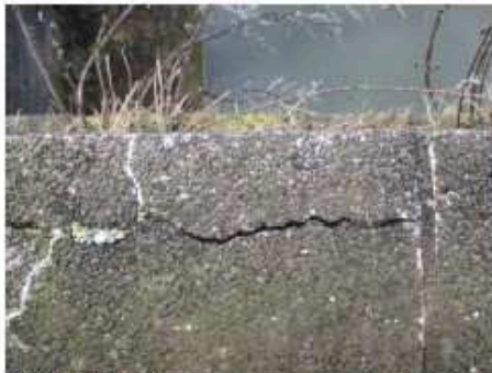
KUNSTWERK (01) Schade: De betonnen randelementen op de borstwering brokkelen af en vertonen scheurvorming. Oorzaak: Vorstschade. Risico: Verminderde functionaliteit. Maatregel: Vervangen betonnen randelementen.
