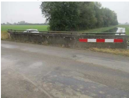
Brug Doesburgseweg voor renovatie
