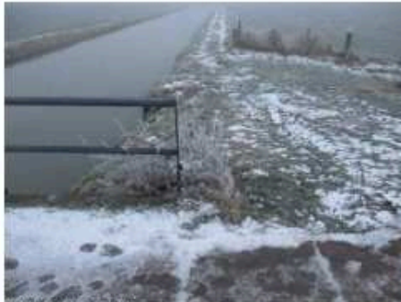
KUNSTWERK (09) Schade: Leuninguiteinde ontbreekt. Oorzaak: Vandalisme. Risico: Verminderde functionaliteit. Maatregel: Aanbrengen ontbrekend leuninguiteinde.
