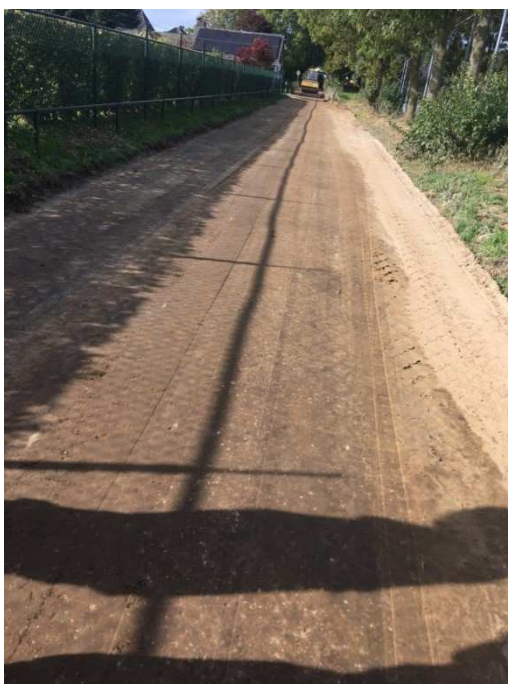
Resultaat direct na grondstabilisatie
