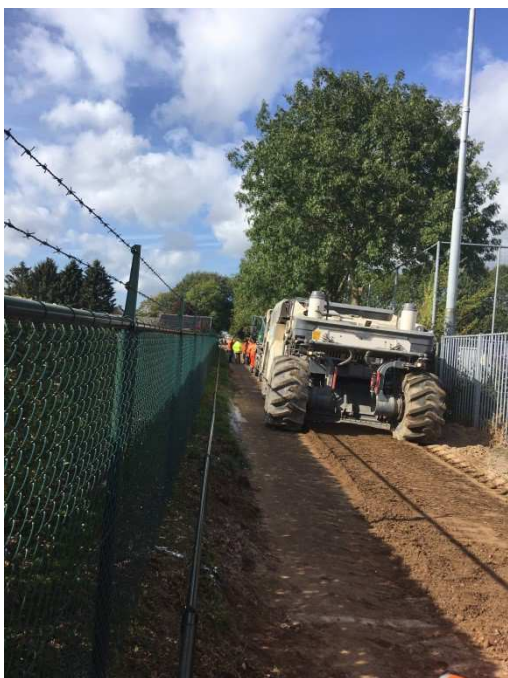
Uitvoering werkzaamheden grondstabilisatie
