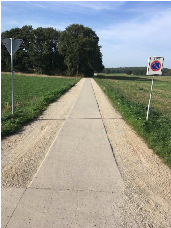
Oude Eltenseweg: Betonnen fietspad op een onverharde weg
