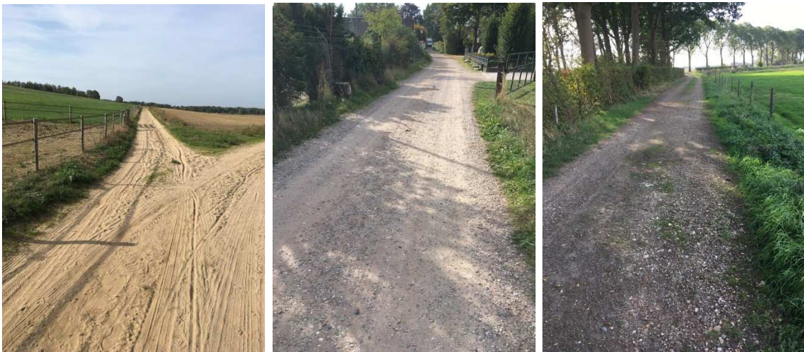
Diverse onverharde wegen: zandweg, puin/zandweg en puinweg
