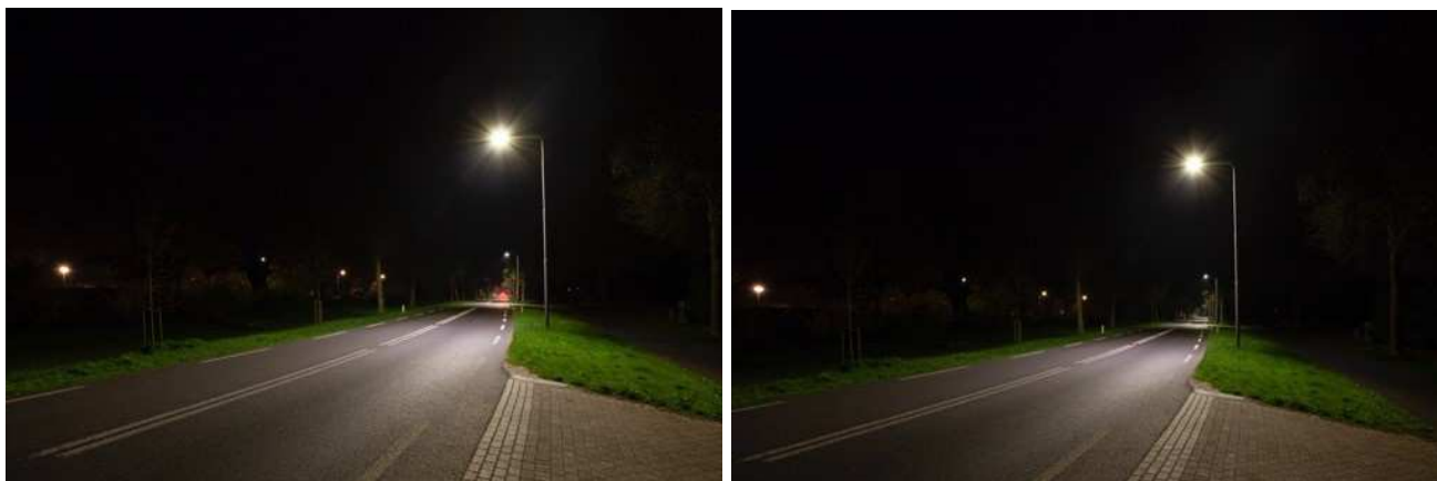
Foto: Hengelderweg in Didam. Links brandt het licht brandt op volle sterkte tot 23.00 uur en rechts op 70% tussen 23.00 en 05.00 uur. Er is na de spits minder verkeer op straat, de ogen zijn gewend aan het donker, er is zo minder lichthinder en we besparen energie.
