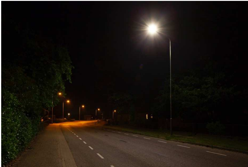
Foto: 's-Heerenbergseweg in Lengel. Twee kleuren licht. Voorgrond wit licht met goede kleurherkenning en achterin oranje licht die geen goede kleurherkenning geeft.
