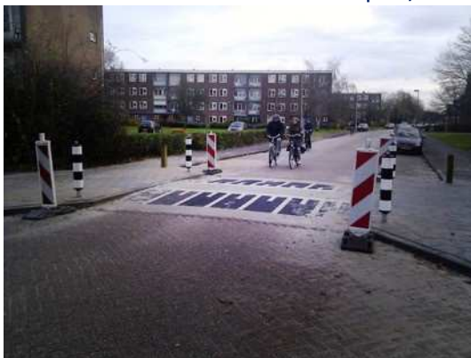
Foto: Wegversmalling elders in het land waarbij reflectie is toegepast om de verhoging in het donker te zien.
