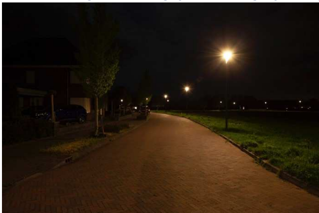
Foto: Potstal in Beek; licht is gelijkmatig over de weg verdeeld waardoor er geen zwarte vlekken ontstaan op het wegdek.
