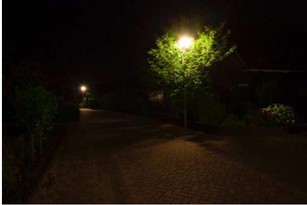
Foto: Oude Kapelstraat in Lengel. Verlichting staat in de boom waardoor er geen goed licht is op de weg.
