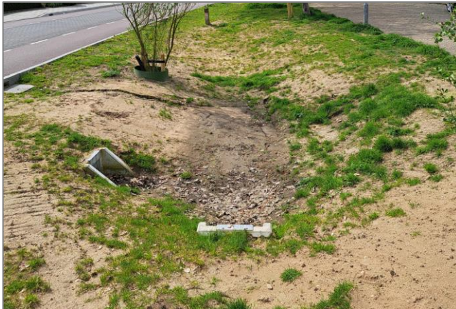
Afbeelding 41: uitstroombak beton geplaatst in talud van wadi
