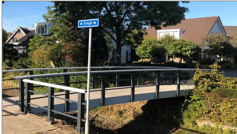
Afbeelding 23: brugconstructie van glasvezelversterkt kunststof
