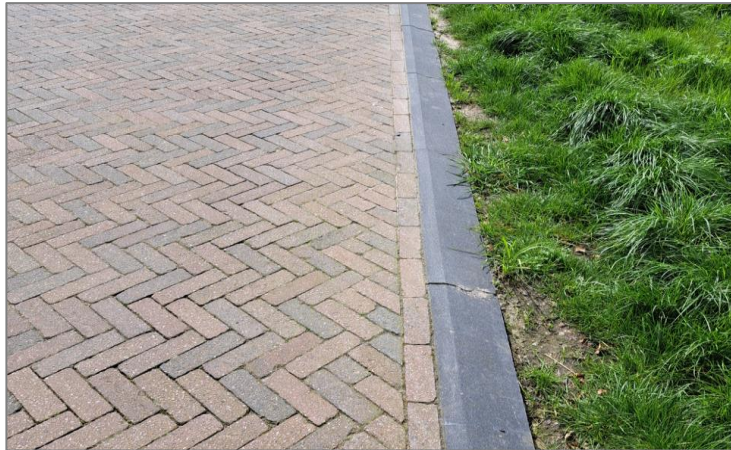
Afbeelding 38: hemelwater laten afstromen via verhard oppervlakte naar de berm
